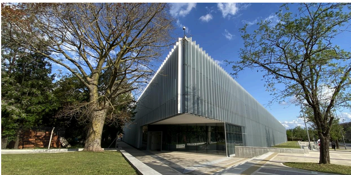
Figura 1: Ingreso al Edificio.
